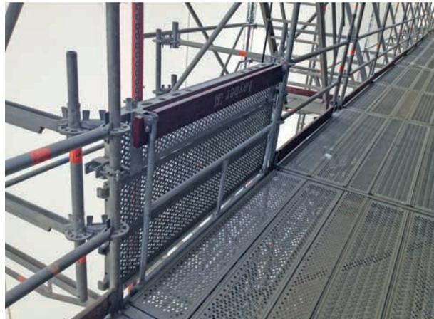
En position verticale, le plancher de la trappe rabattable sert de garde-corps.
