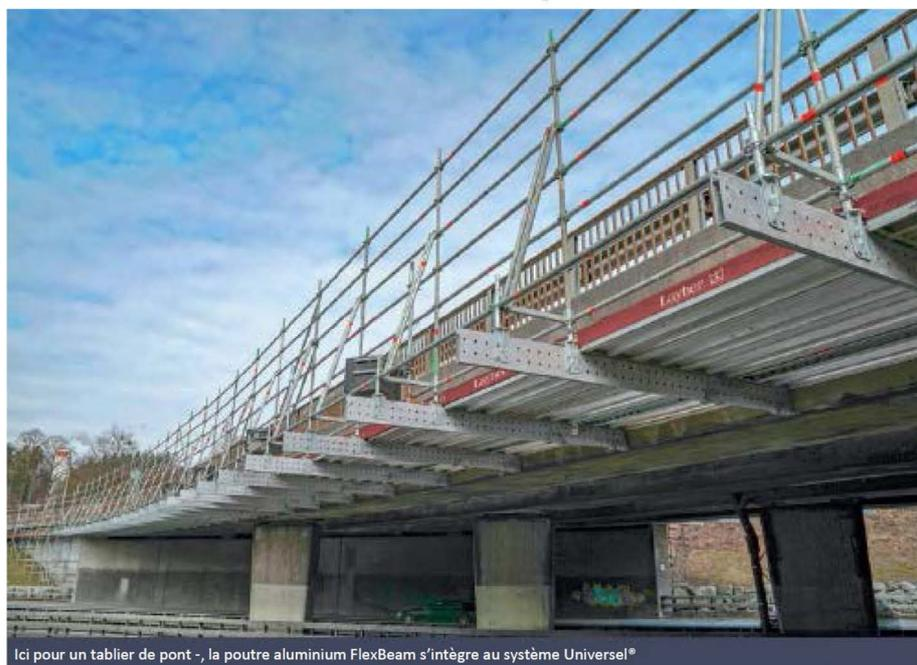
Ici pour un tablier de pont -, la poutre aluminium FlexBeam s'intègre au système Universel®
