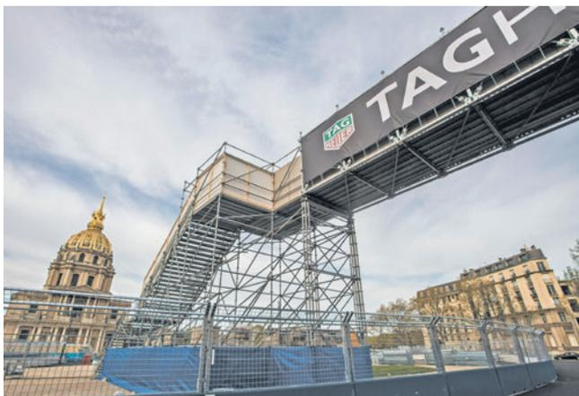
L'Universel se décline dorénavant dans sa version Lightweight, utilisant un **acier haute résistance** élastique lui conférant une **résistance accrue à la charge**, un **gain de poids** conséquent.
